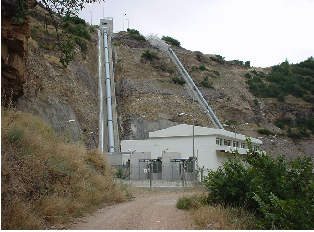
Şekil 2. Sulama kanalından beslenen küçük bir hidro elektrik tesis. (Çal, DENİZLİ).
