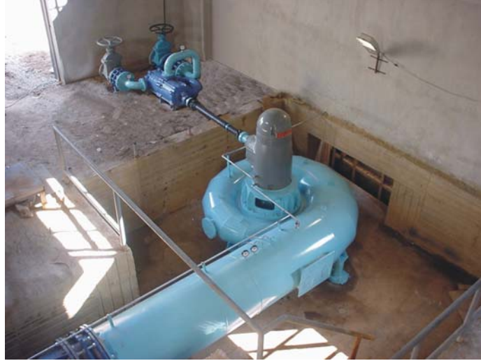
Şekil 18. Yerine monte edilmiş türbin-redüktör-pompa gurubu.
