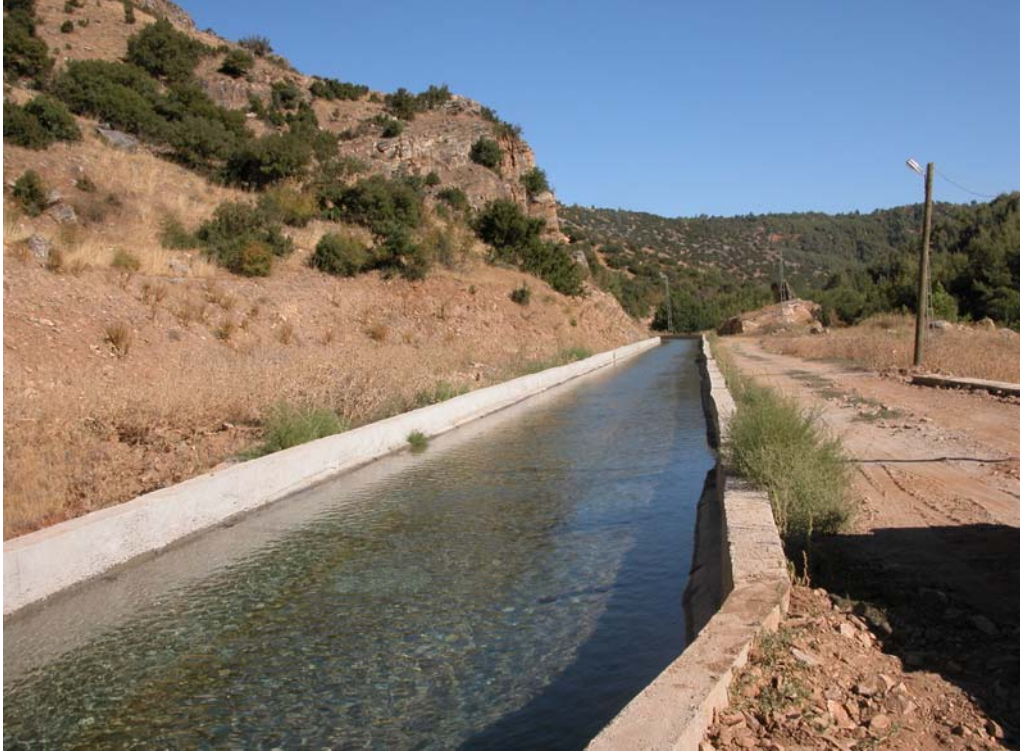
Şekil 3. 200kW lık bir mini tesise su getiren 2\text{m}^3/\text{sn} debili su kanalı.
